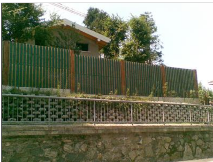
Figura 14 – Barriere artificiali con pannellatura in legno
