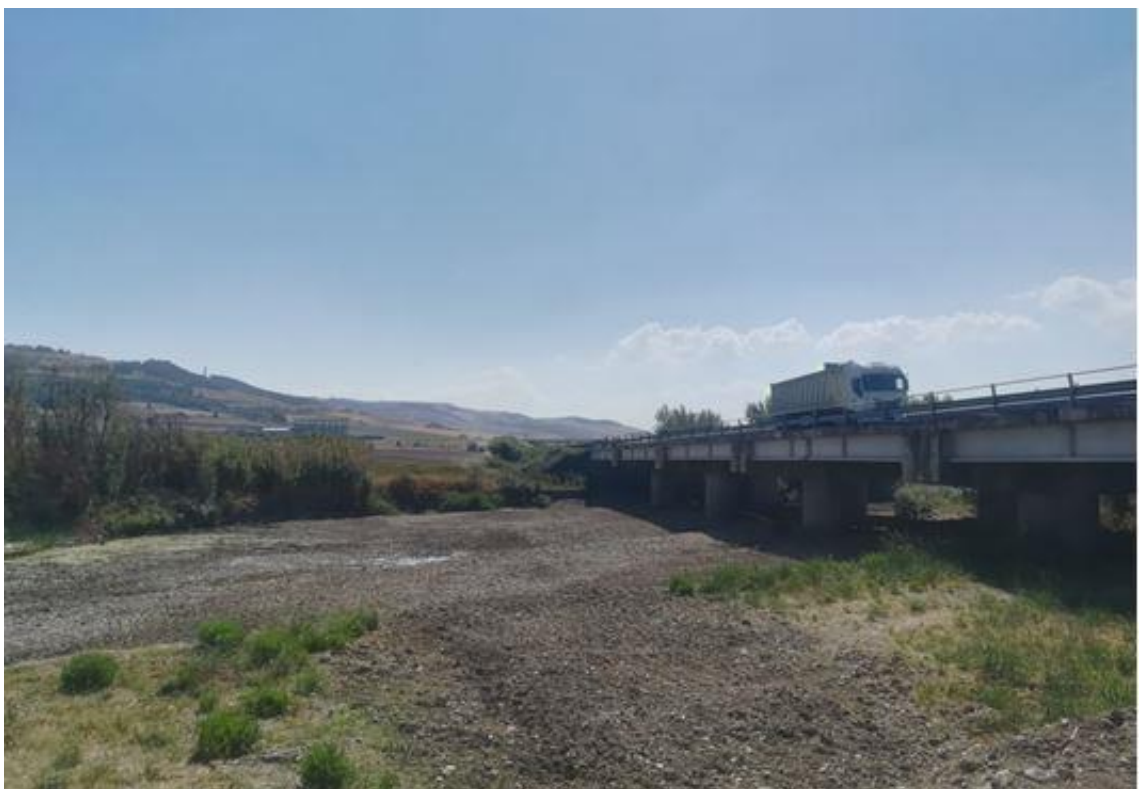
Foto 2 - Torrente Carapelle, CA_CR02 Situazione alla data del 14/09/2021
