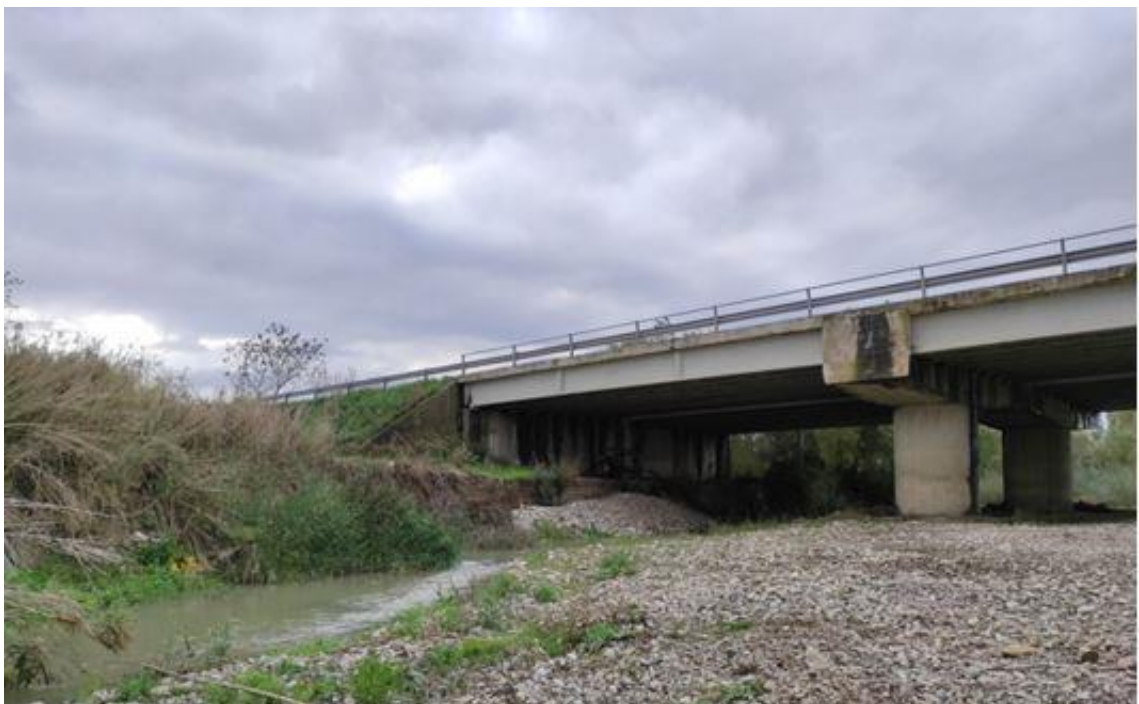
Foto 4 - Torrente Carapelle, CA_CR02 Situazione alla data del 19/11/2021
