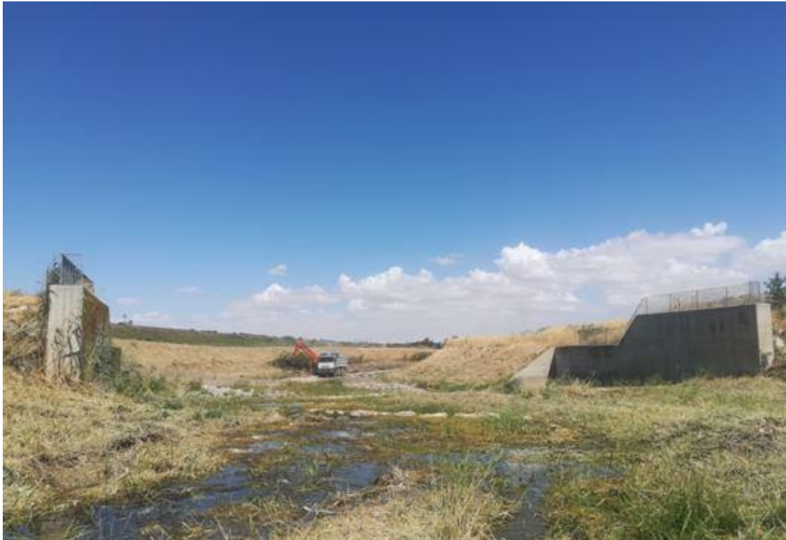
Foto 1 - Torrente Carapelle, CA_CR02 Tratto a valle dello scolmatore - 16/07/2021
