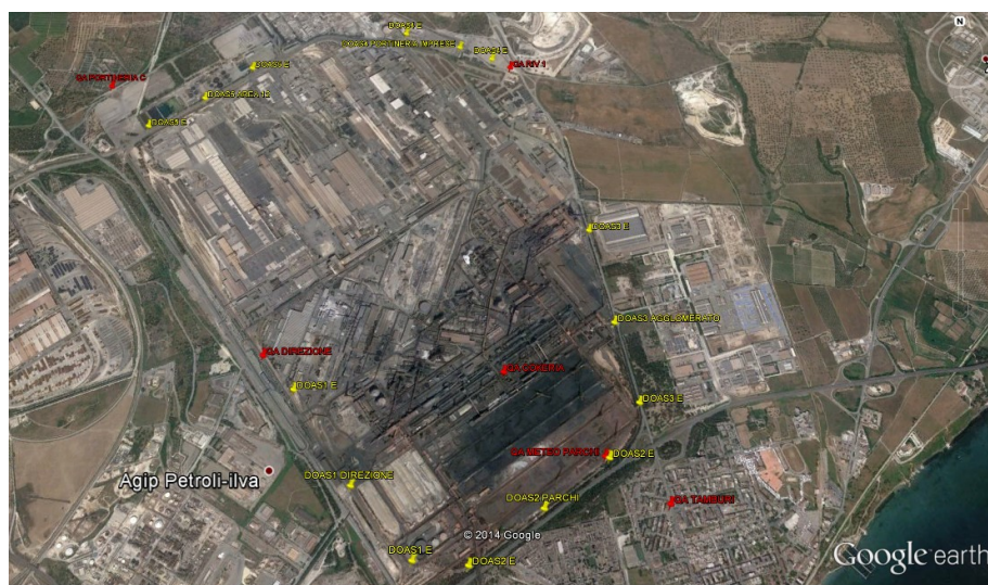
Fig.1 - Dislocazione delle postazioni di monitoraggio
