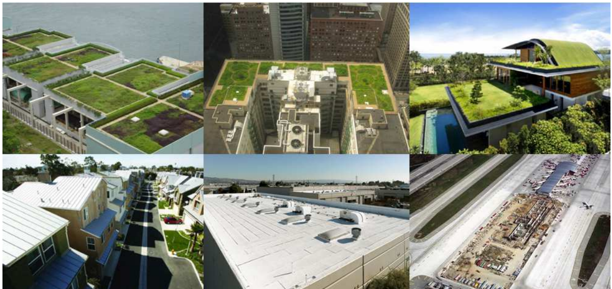
Figura 7 Alcuni esempi di mitigazione dell’ICU: tetti verdi (green roofs) in alto, tetti e superfici “fresche” (cool roofs and surfaces) in basso.
