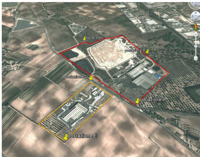
Figura 3 – Particolare impianto di biostabilizzazione
