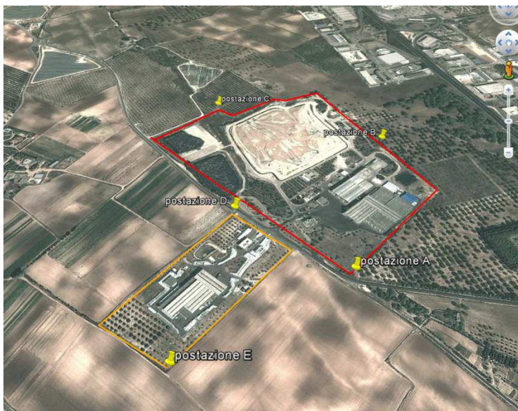
Figura 3 – Particolare impianto di biostabilizzazione
