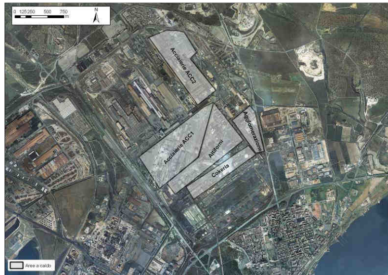
Figura 2.5.2 Localizzazione delle sorgenti areali (area a caldo) presenti all'interno dello stabilimento ILVA di Taranto
