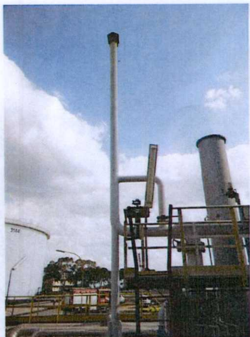
Figura 6 Impianto di recupero vapore S4 (URV serbatoi olio combustibile). Particolare del punto di emissione, del misuratore di flusso e del sistema di bypass.
