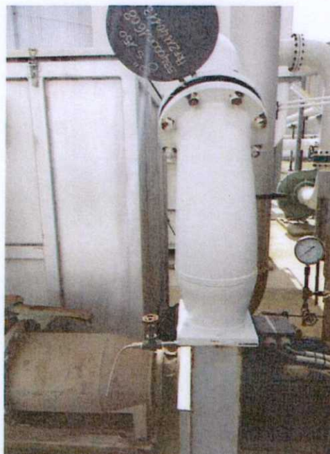
Figura 9 Impianto di recupero vapore S4. Punto di prelievo campioni per l'analisi degli effluenti gassosi.
