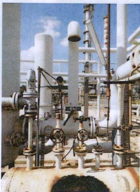
Figura 3 Impianto di recupero vapore S2. Particolare di uno sfiato diretto in atmosfera.
