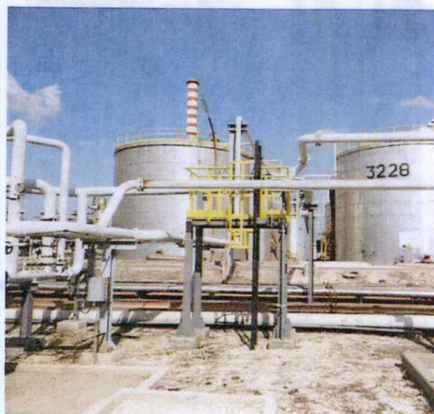
Figura 2 Impianto di recupero vapore S2. Particolare del punto di prelievo campioni per l'analisi degli effluenti gassosi.
