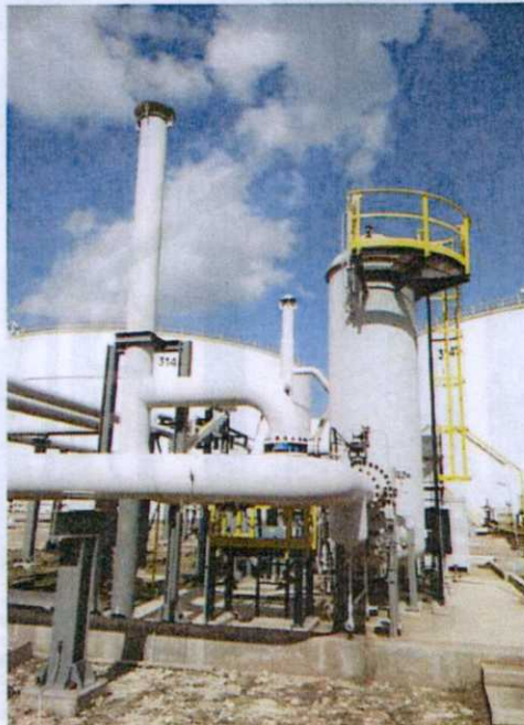
Figura 5 Impianto di recupero vapore S4 (URV serbatoi olio combustibile).
