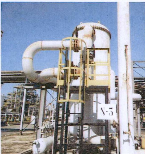
Figura 10 Impianto di recupero vapore S3 (URV caricamento pensiline bitume).
