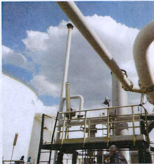
Figura 6 Impianto di recupero vapore S4 (URV serbatoi olio combustibile). Particolare del punto di emissione, del misuratore di flusso e del sistema di bypass.
