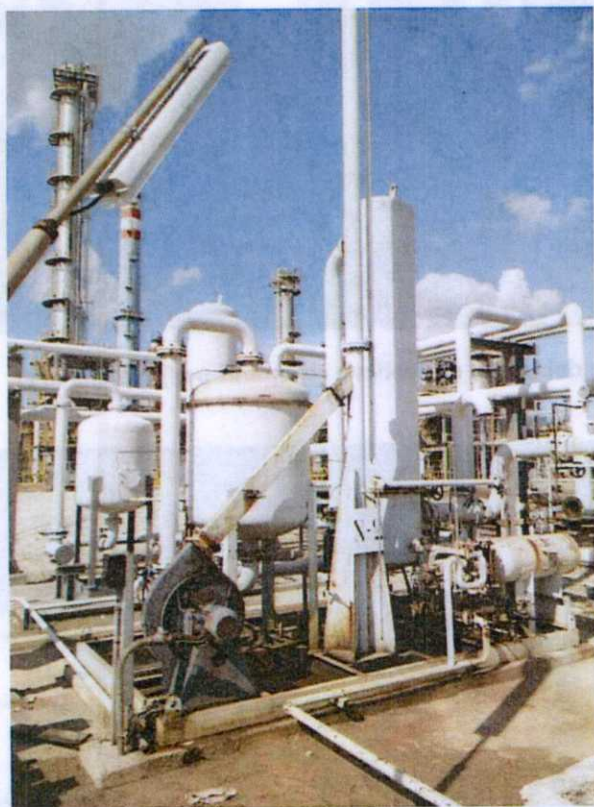
Figura 1 Impianto di recupero vapore S2 (URV serbatoi bitume 2).
