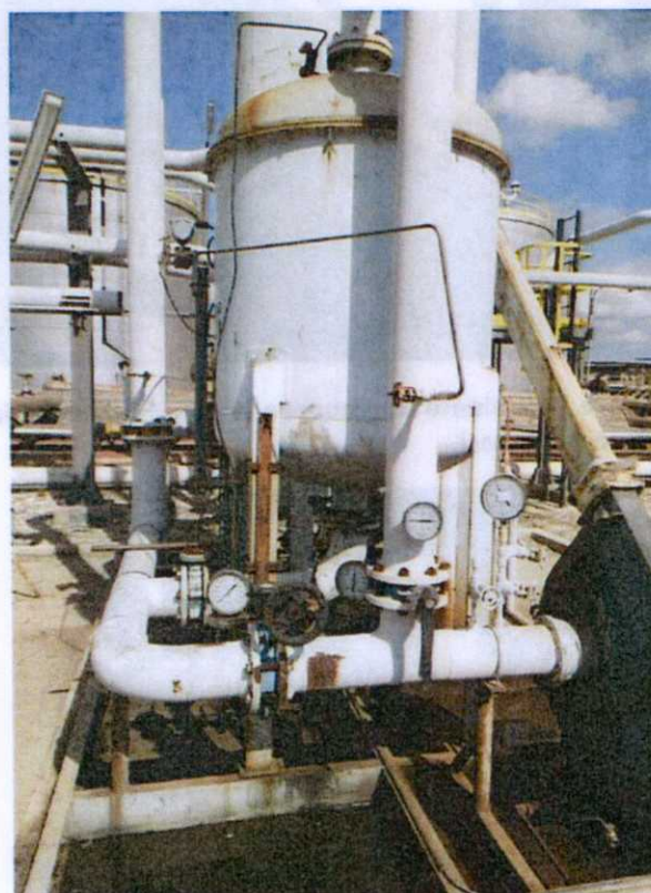
Figura 1 Impianto di recupero vapore S2 (URV serbatoi bitume 2).
