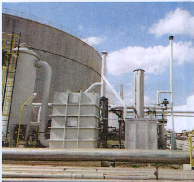
Figura 5 Impianto di recupero vapore S4 (URV serbatoi olio combustibile).
