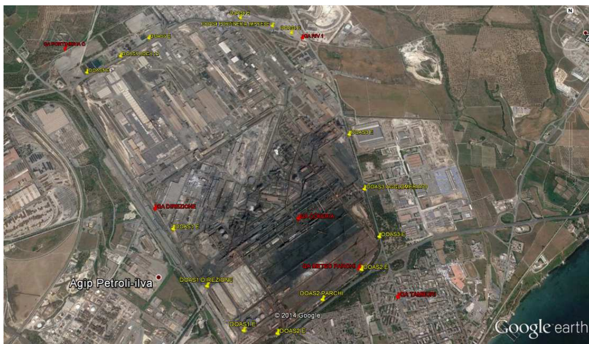
Fig.1 - Dislocazione delle postazioni di monitoraggio
