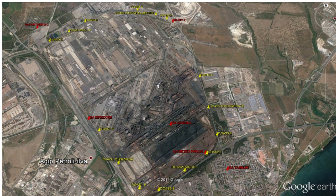
Fig.1 - Dislocazione delle postazioni di monitoraggio
