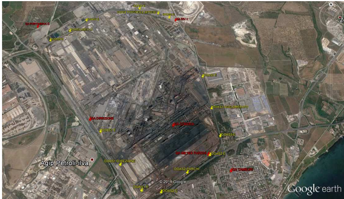
Fig.1 - Dislocazione delle postazioni di monitoraggio
