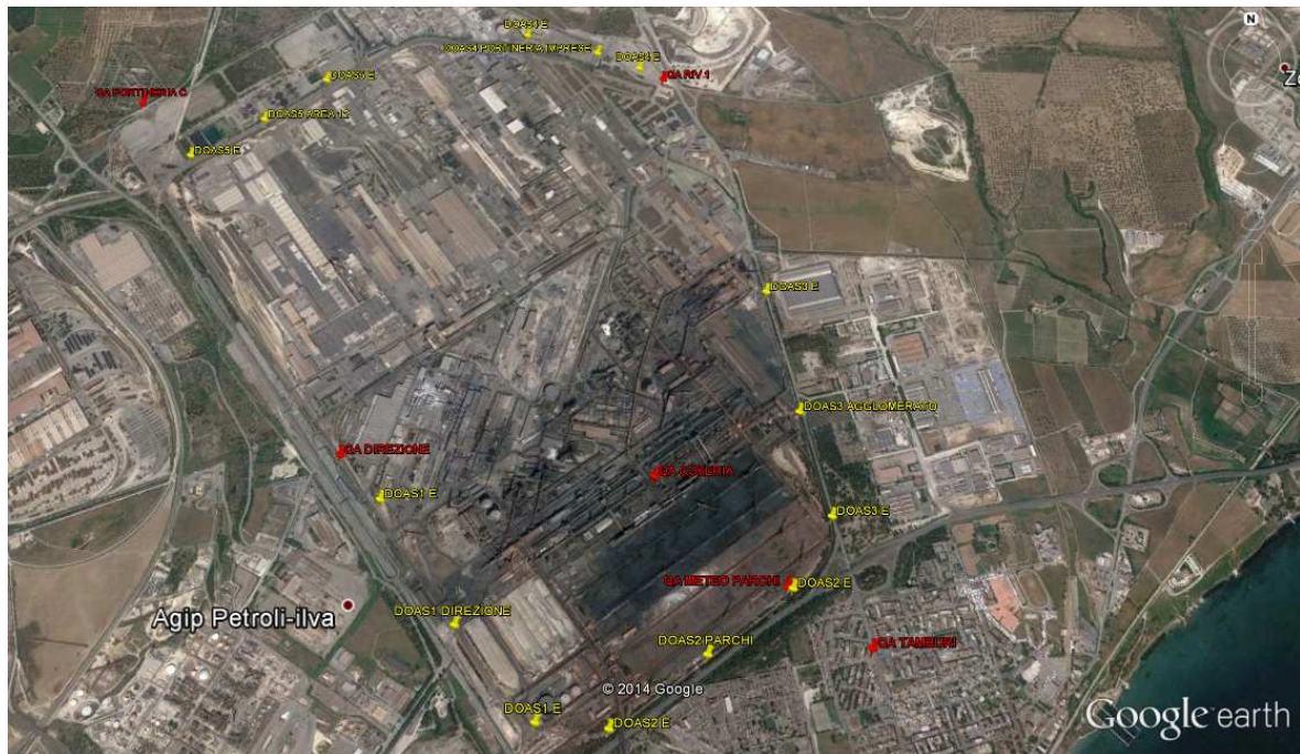
Fig.1 - Dislocazione delle postazioni di monitoraggio
