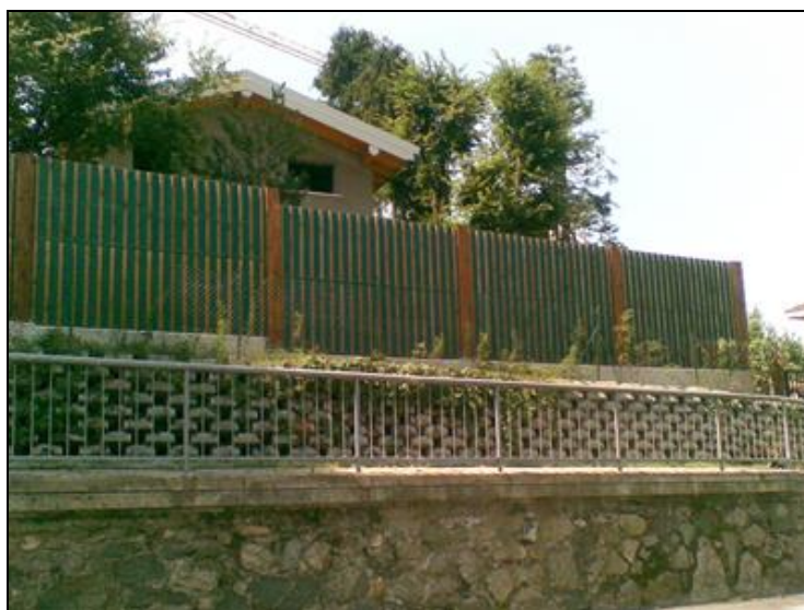
Figura 18 – Barriere artificiali con pannellatura in legno
