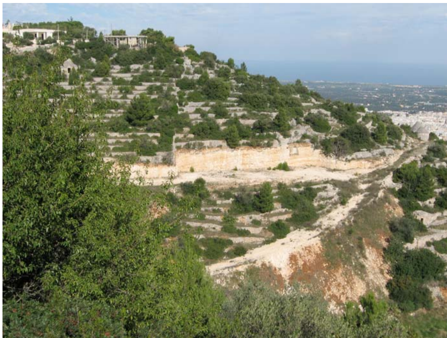
Foto 3 – Fasano, muretti a secco per la protezione delle scarpate
