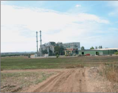
Fig 1.11 Impianto di incenerimento
