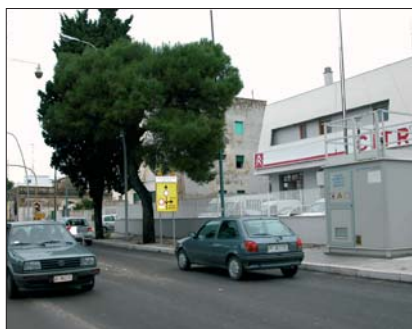
Fig. 1.3 Stazione di monitoraggio mal posizionata
