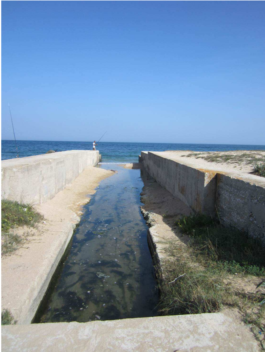
Fig. 58. Un ulteriore canale di comunicazione tra il sistema idrografico retrodunale ed il mare.
