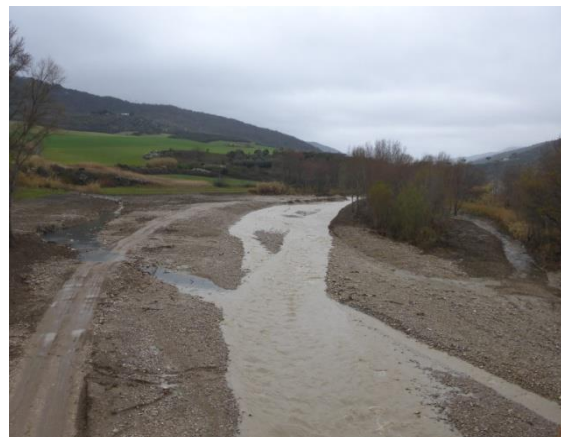
Lavori di arginatura sul T. Cervaro (CA_CE01) - 6 marzo 2017
