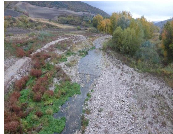
Lavori di arginatura sul T. Cervaro (CA_CE01). Ripresa della vegetazione spontanea dopo abbattimento della fascia perifluviale - 14 novembre 2017
